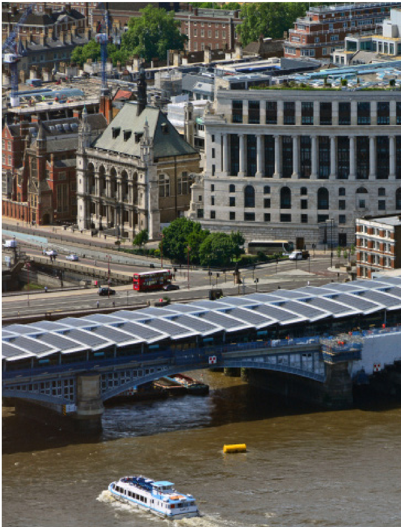
ロンドン・ブラックフライアーズ駅プラットホームの太陽電池パネルの屋根 ©Justin Kasezsiz/Alamy Stock Photo
